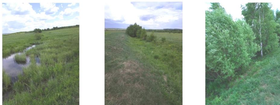
Рисунок 6 – Регулирующая открытая сеть на юго-восточном участке в районе населенного пункта Верхний Кукут
